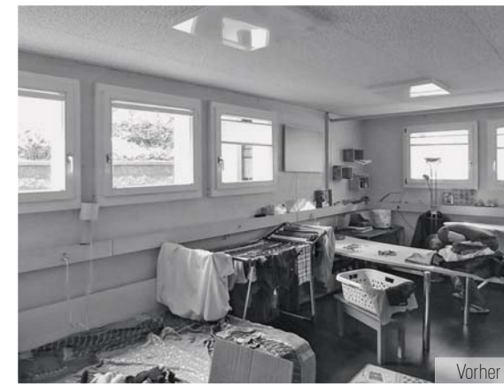
Vorher Der Wohnbereich gegen Norden ist nicht unterkellert und war gegen das Erdreich ungedämmt.
